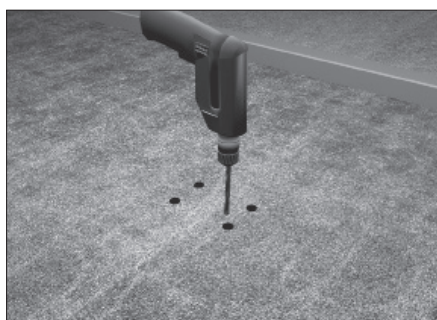
Просверлите 4 отверстия \varnothing 13 в дорожном покрытии.
